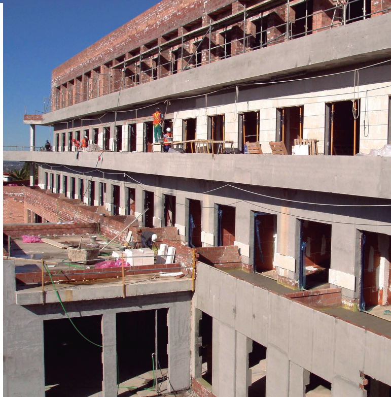
Situación de las obras al 30 de Octubre de 2012
